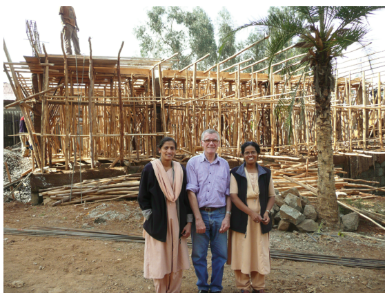
Prof. Bosman vor dem Rohbau des Schwesternwohnheims in Addis Abeba.
